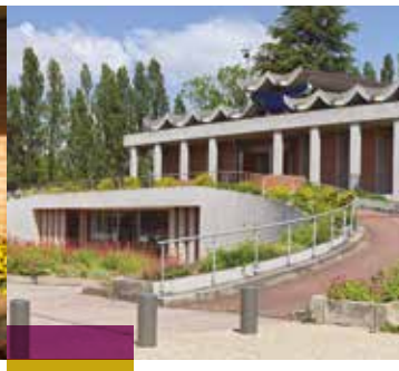
Un crématorium entièrement rénové pour l'accueil des familles, avec un ascenseur pour les personnes à mobilité réduite (PMR) est équipé d'une nouvelle ligne de filtration afin de réduire les rejets atmosphériques.
