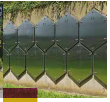
Des enfes aménagés en hauteur.
